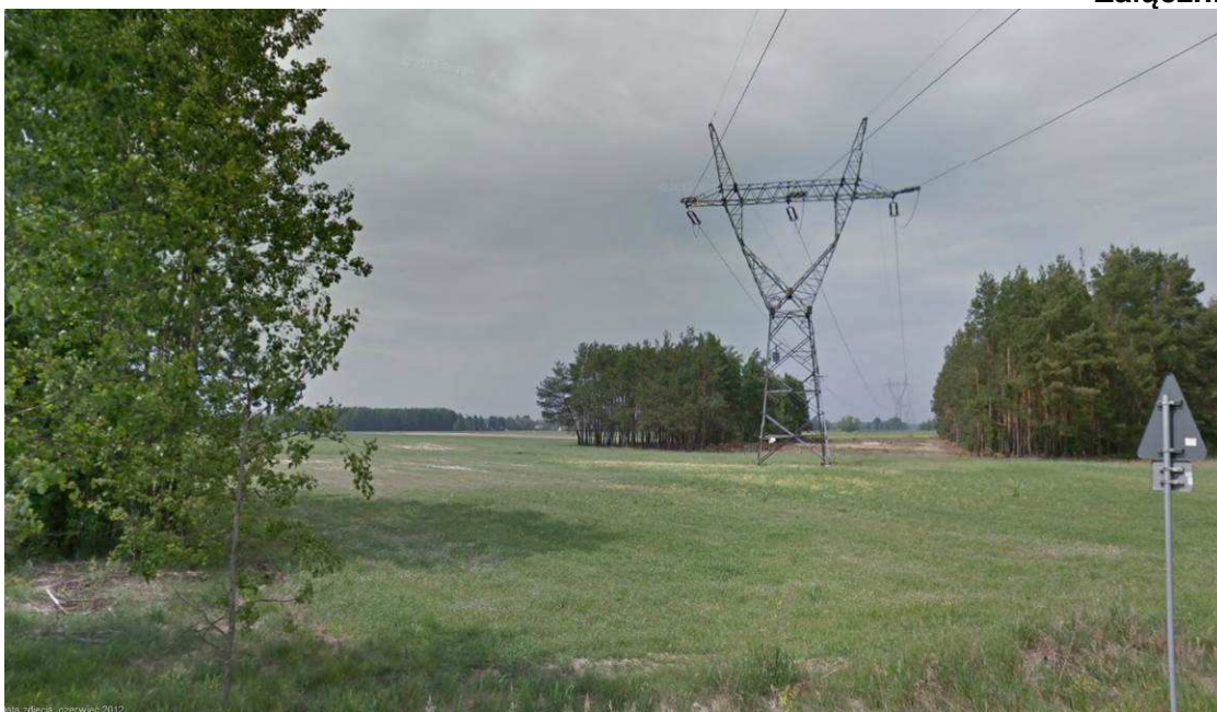
Fot. 1 Widok na istniejącą linię elektroenergetyczną 220 kV i wycięty pas lasu (z drogi wojewódzkiej nr 614 w kierunku północno – zachodnim).
