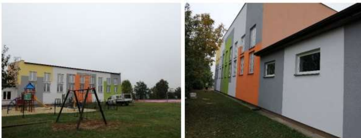
Rysunek 8. Termomodernizacja budynku Szkoły Podstawowej w Surowem
