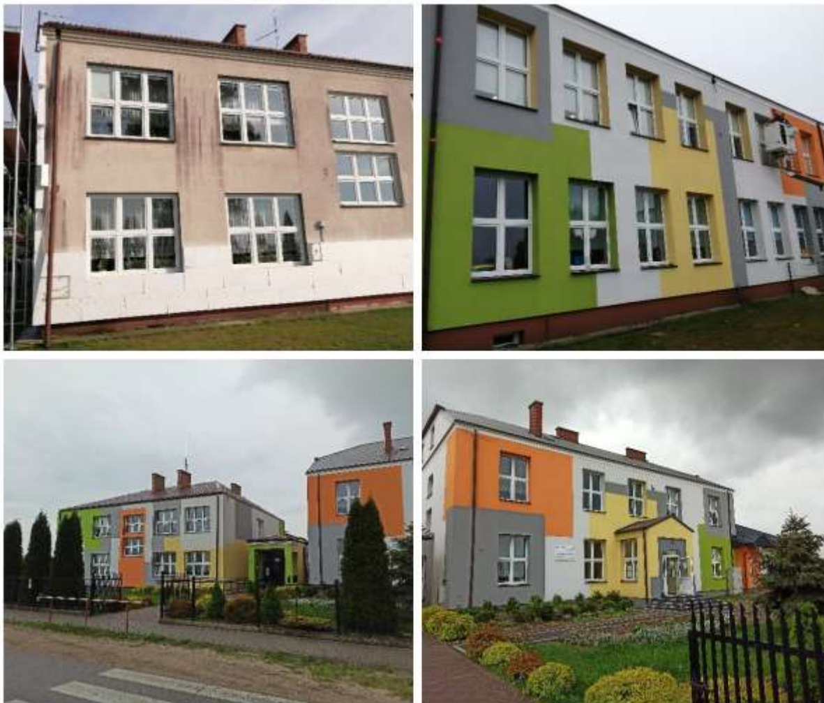
Rysunek 7. Termomodernizacja budynku Szkoły Podstawowej w Surowem (przed i po)
