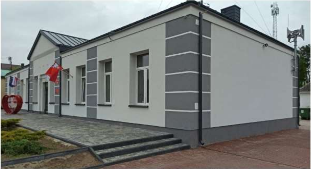
Rysunek 10. Termomodernizacja budynku Urzędu Gminy w Czarni
