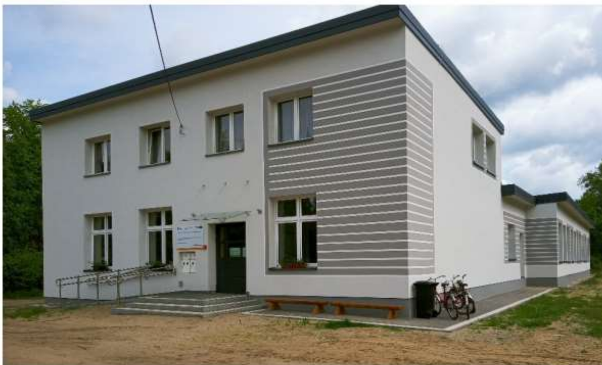
Rysunek 16. Termomodernizacja budynku Centrum Aktywności Lokalnej w Długiem
