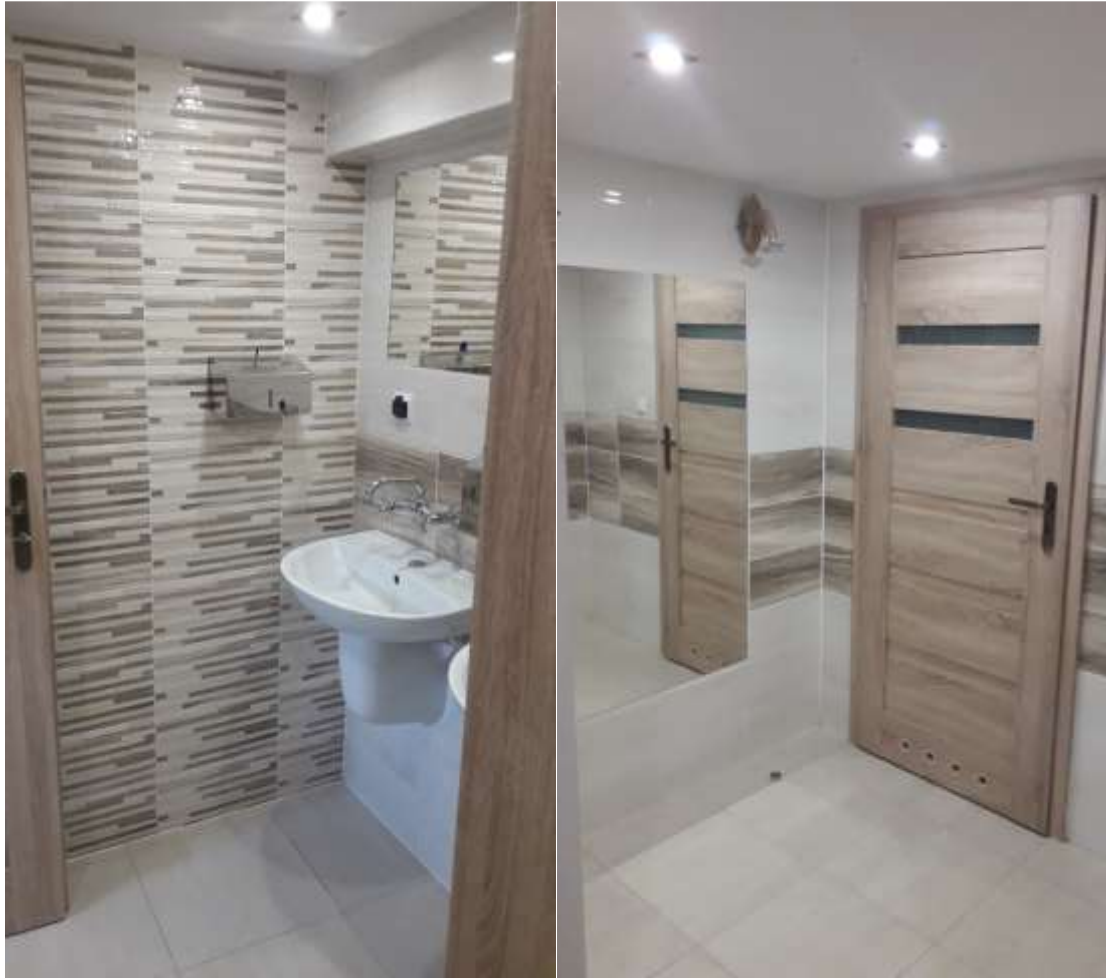
Rysunek 12. Remont pomieszczeń sanitarnych w OSP w Czarni
