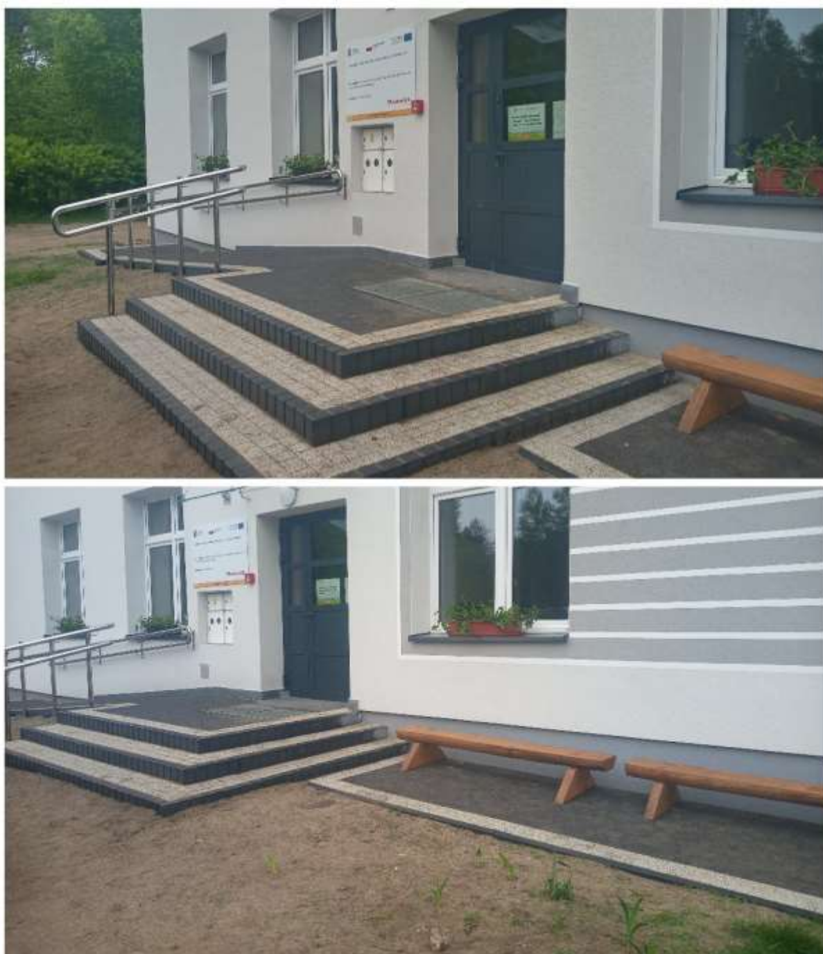
Rysunek 17. Termomodernizacja budynku Centrum Aktywności Lokalnej w Długiem
